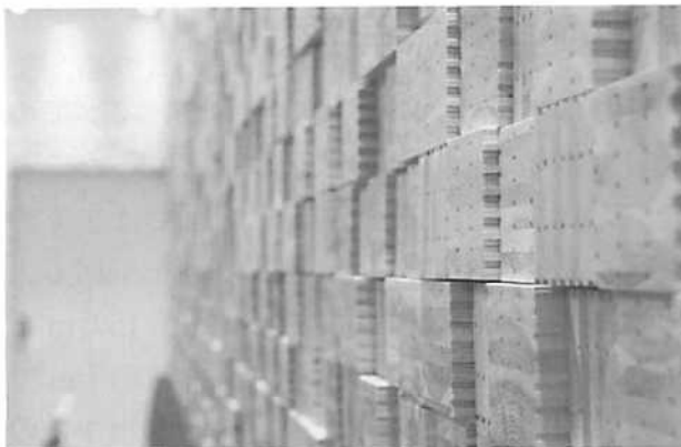
ルクア大阪店。尾鷲産ヒノキフローリングの端材を張り合わせた材料を壁にレイアウトした（SSTのWebサイトから）
