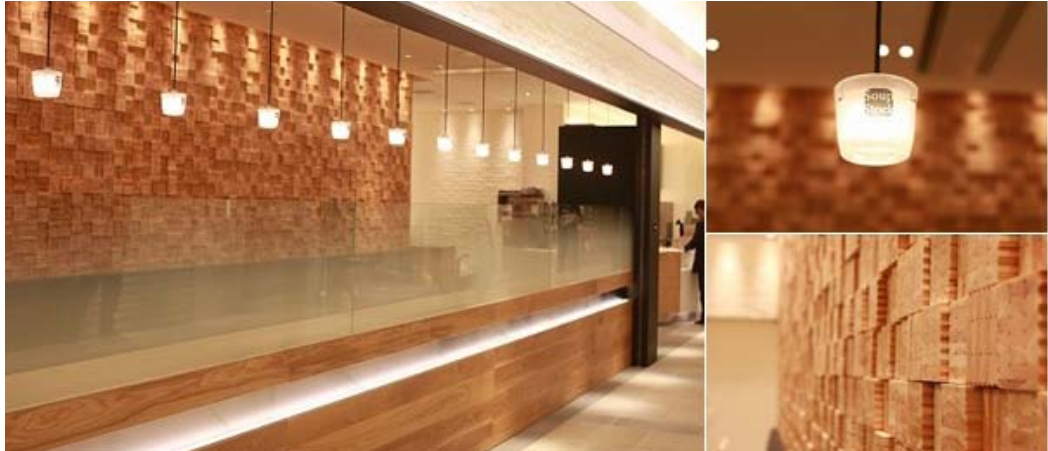
B品フリーリング材をリサイクルした壁面
